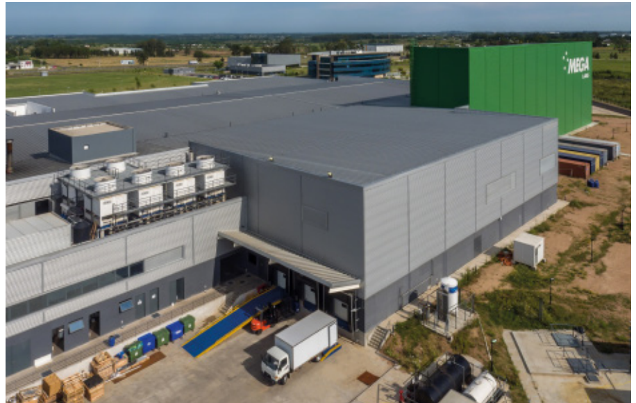
Les quais de chargement et de déchargement sont séparés afin d'éviter des interférences entre les deux opérations.
