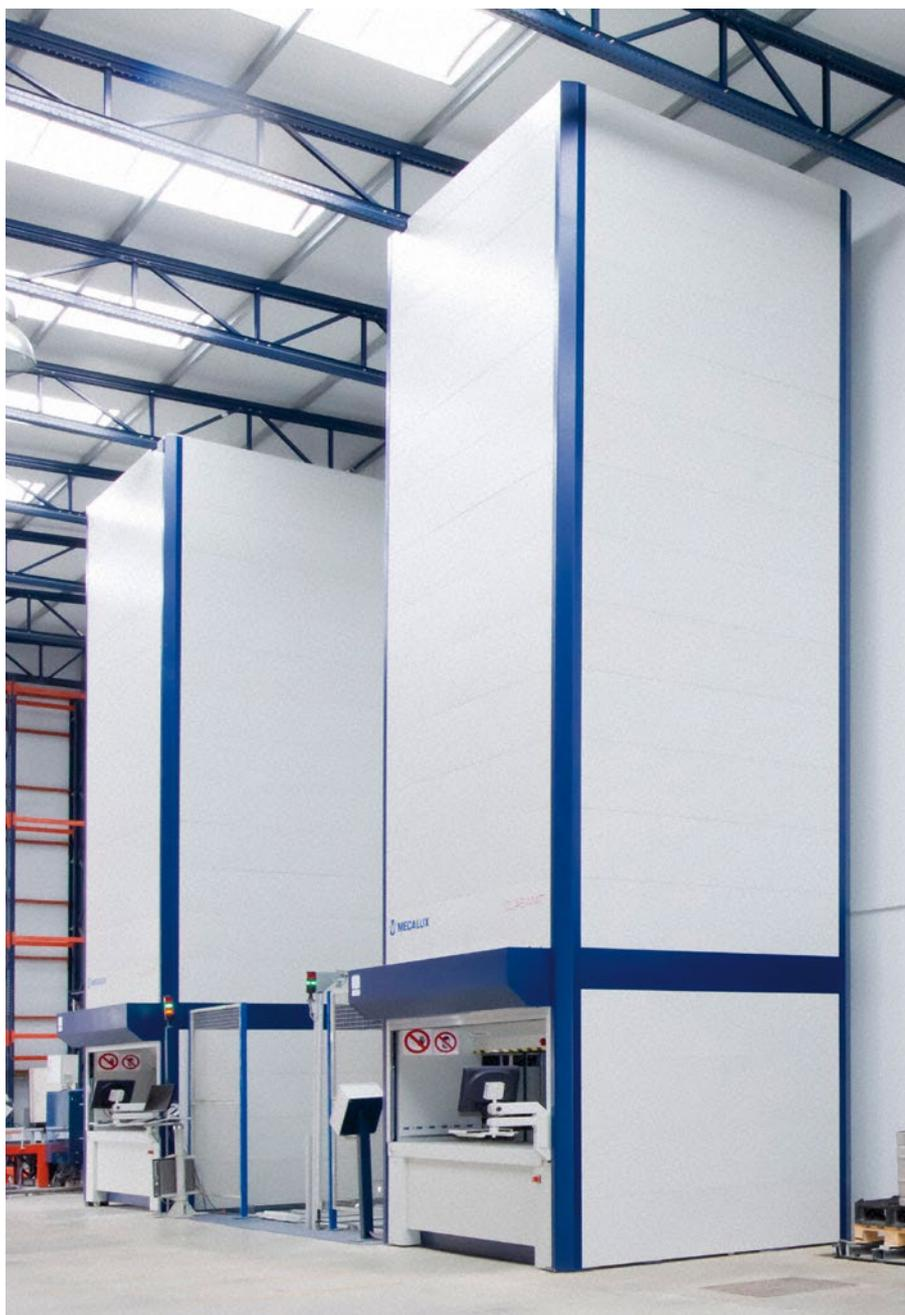
Le Clasimat est un système de stockage vertical automatique pour produits légers, qui optimise au maximum l'espace de stockage et augmente en même temps l'efficacité des opérations de picking
